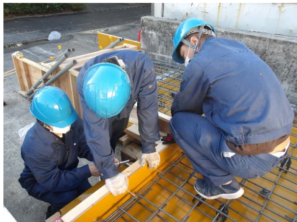
図6 R C造の階段を製作中
