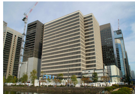
解体中の「りそな・マルハビル」
