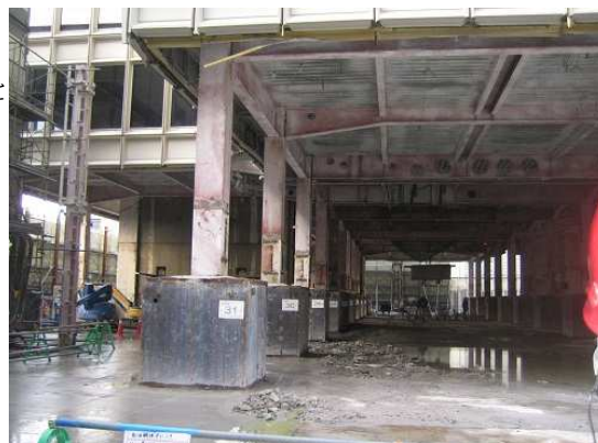
ジャッキダウン前の現場状況
