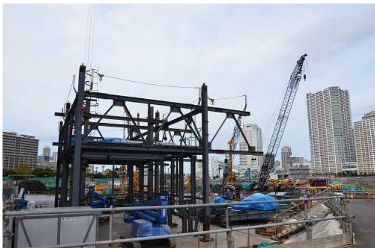
ヤードで地組されるタワーパーキングの鉄骨
