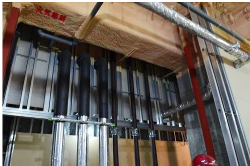
集合配管も将来的に容易に更新ができるよう計画されている
