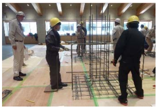
柱筋組み立て
