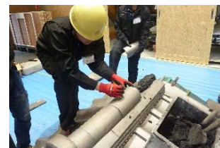
和瓦葺き (棟瓦)
